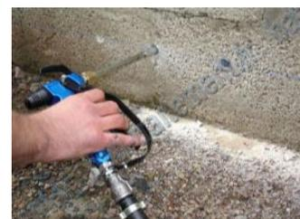
Effectuer un premier remplissage des trous. Attendre 72 heures et effectuer un deuxième remplissage. Et 72 heures après le deuxième remplissage sonder les trous à l'aide d'une tige. Si le fond du trou sondé est sec, un troisième remplissage sera nécessaire.
